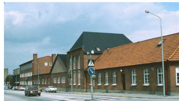
Bild 3: Industriområdet Norra Sorgenfri 1979.
